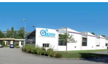
Nouvelle unité de production
